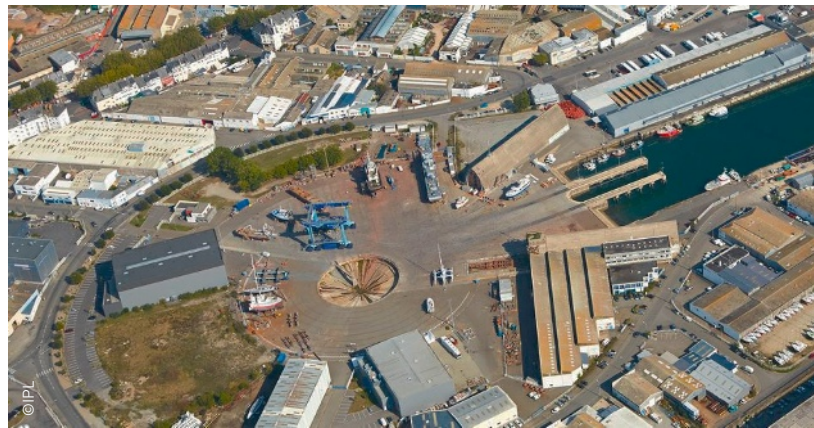
L'aire de réparation navale de Lorient Kermoan a accueilli 256 navires en 2023.
